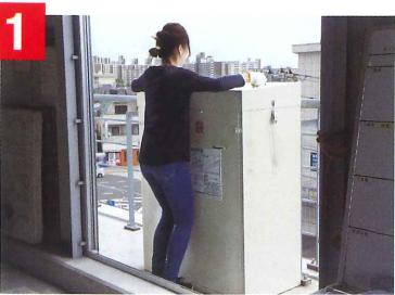
格納箱の上ぶたの止め金具を外し、上ぶたを取り除き、前板の止め金具を外し、前板を取り除き窓を開けます。(手前引き式は、格納箱を手前に引いて取り除きます。)
