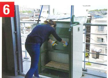
取付具のステップを手前に倒しセットします。
