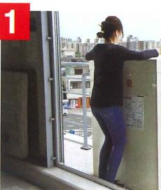
格納箱の上部の止め金具を外し、上部を取り除き、前板の止め金具を外し、前板を取り除き窓を開けます。(手前引き式は、格納箱を手前に引いて取り除きます。)
