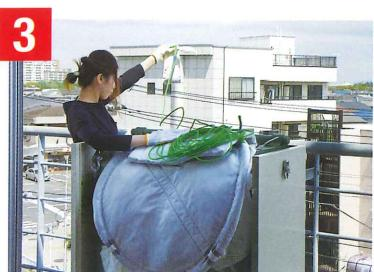
地上と降下空間に障害のないことを確認して、砂袋のついている誘導網を投げ降ろします。
